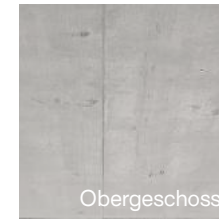
Beton roh Obergeschoss
